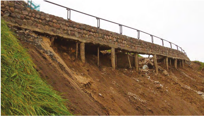
18 pav. Gedimino kalno pietrytinis šlaitas su atsidengusiais poliais po taku, 2017 m. vėlyvo rudens nuošliauža. V. Mikulėno nuotr.
