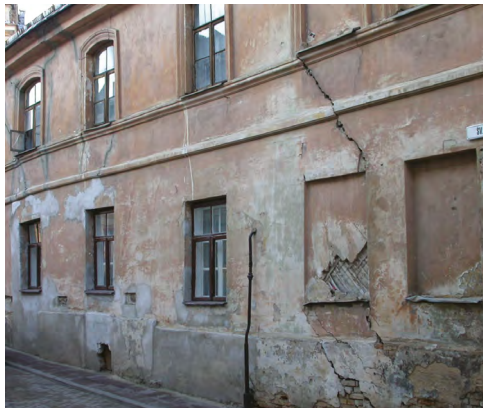
26 pav. Plyšiai name Šv. Ignoto g., Vilniuje, 2004 m. S. Gadeikienės nuotr.
