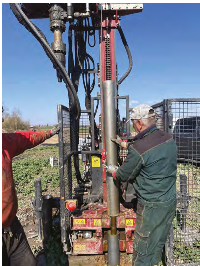
1 pav. Gręžinys įrengiamas vibraciniu sukamuoju būdu, Telšių r., 2022 m. (UAB „Geotestus“).
