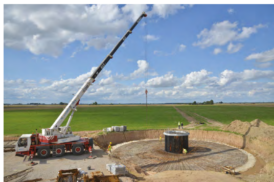
5 pav. Vėjo jėginės pamatų įrengimas ( https://www.projektana.lt/projektas/projektai/Vejo-jegainiu-parkai ).
